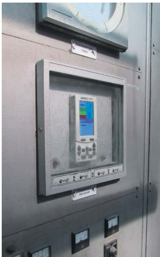
▲ Рис. 3. Регулятор уровня БАЗИС-14.Р
